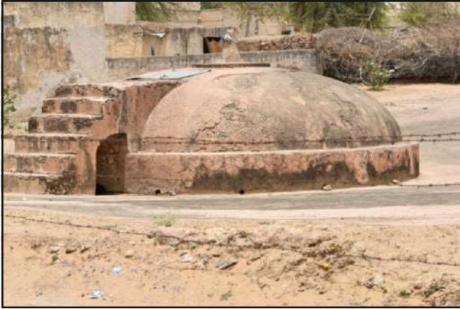
चूरु जिले में चूना पत्थर की चिनाई व पक्के आगौर वाले निर्मित पुराने मजबूत टांके आज भी उपयोगी हैं
